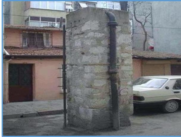
Şekil 9. Su Terazisi Tipindeki Su Tesis Oluşum Yapısı
